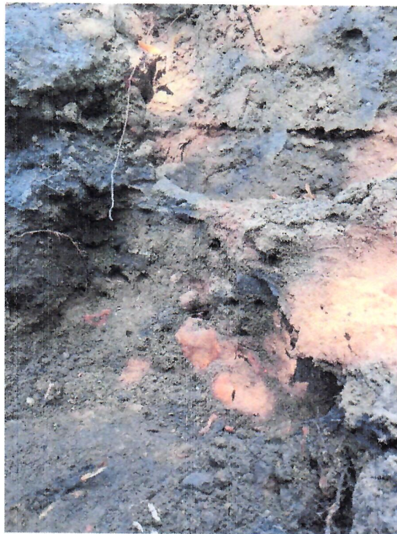
Fotografie z 23 lipca 2024 r. – budowa ciepłociągu (do protokołu)
